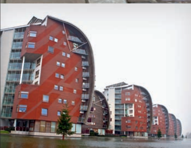
Wonen in de appartementencomplexen van de 'Armada'. De langgerekte vijver is een zonnecollector, als aanvulling op de verwarming van de woningen. Onder de vijver ligt een parkeergarage.
